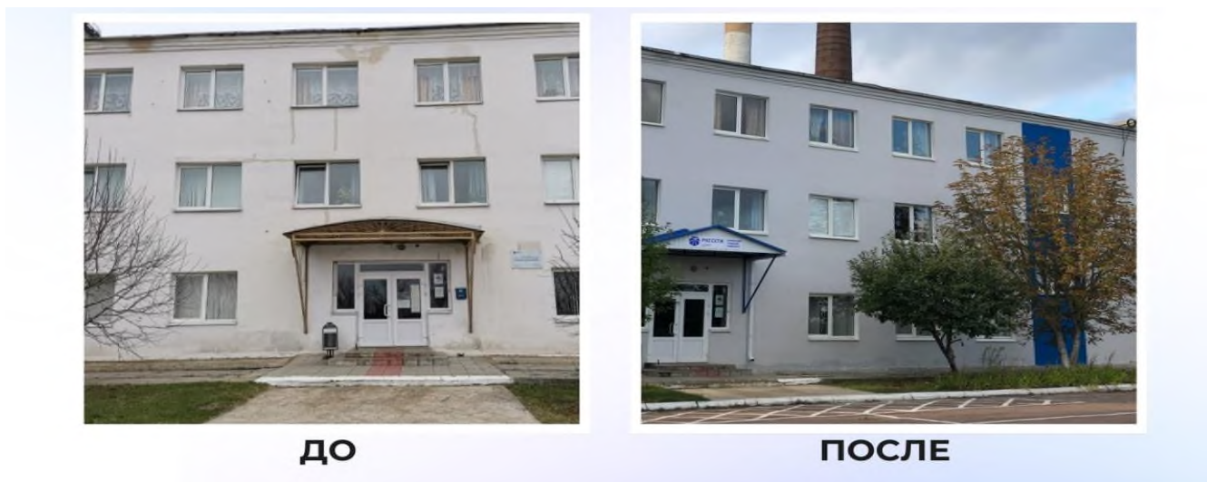
Рис. 5 Здание Орловского УК до и после ремонта фасада
